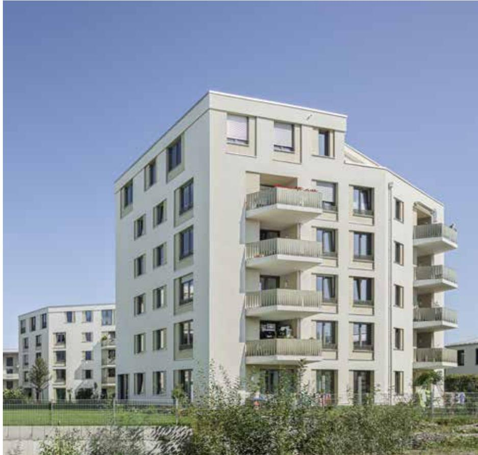
Es geht hoch hinaus. Bis zu sechs Vollgeschosse haben die Gebäude der Kemptner Stiftsstadt-Wohnen. Errichtet in monolithischer Massivbauweise mit speziell für den Geschosswohnungsbau entwickelten MZ-Ziegeln. Dank integrierter mineralischer Dämmstoffpads werden neben hoher Tragfähigkeit, gutem Schall- und Brandschutz auch außergewöhnliche Wärmedämmwerte erreicht.
