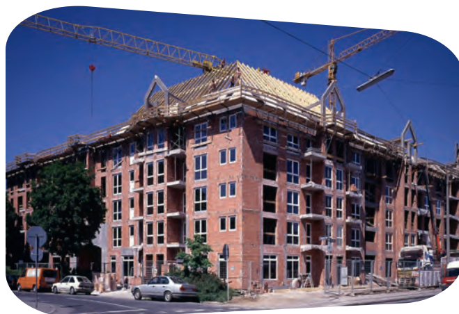
Bild 1 und 2: Homogenes Ziegelmauerwerk
