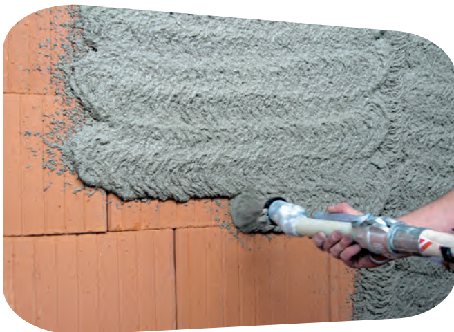
Bild 13: Auftrag des Unterputzes auf Planziegelmauerwerk
